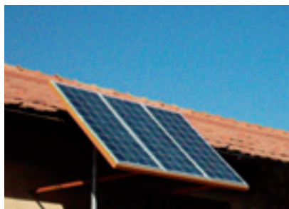
ESEMPIO DI IMPIANTO PARZIALMENTE INTEGRATO
